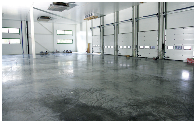
FIN OVERFLATE. Betonggulvet i de nye produksjonslokalene til Bama er stålglattet.
