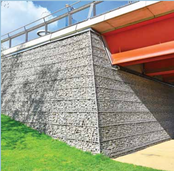
Gabionvegg i knust betong
