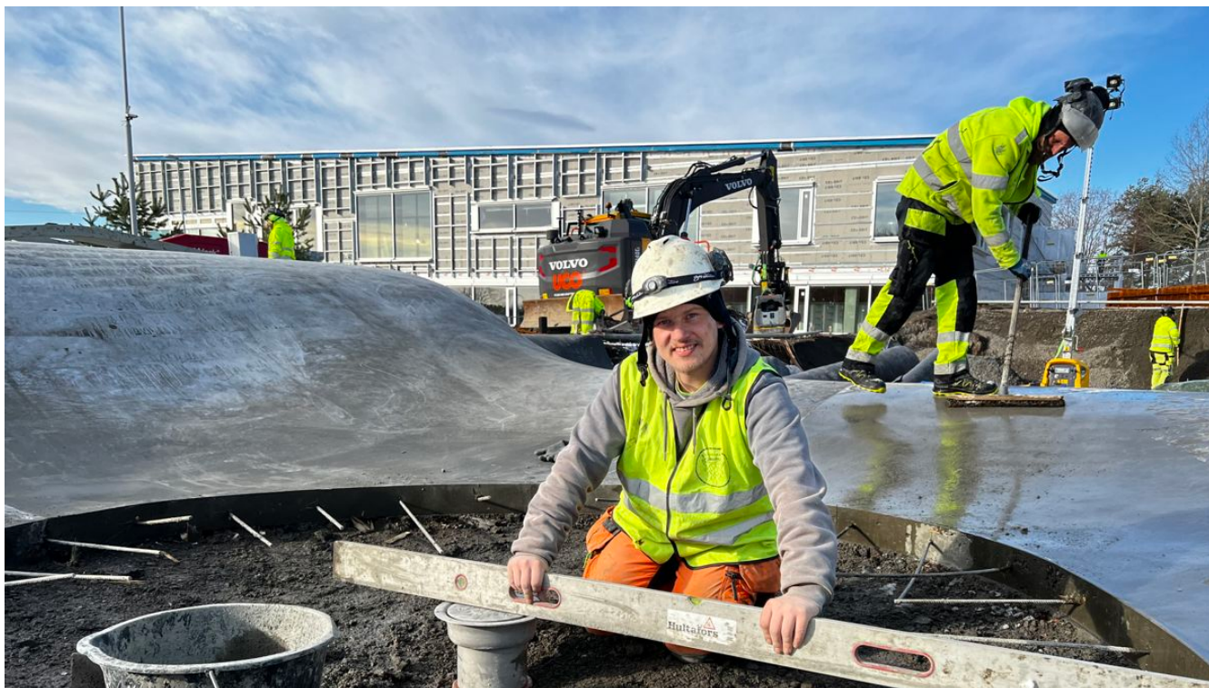
Prosjektleder og skater Robin kombinerer hobby og jobb når han bygger rulleparker for Betongpark. Foto: Svanhild Blakstad
