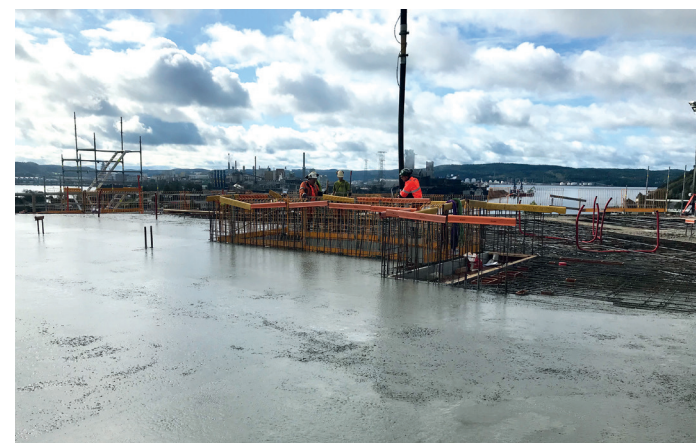
SOM STØPT. På Powerhouse Telemark har hybridbetong blitt brukt i alle plasstøpte konstruksjoner. Foto: Skanska
